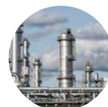
Industrieanlagen Production plants
