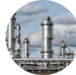
Industrieanlagen Production plants
